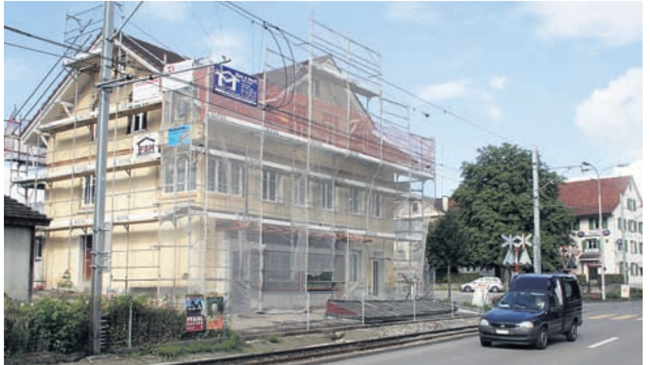
Das Geschäftshaus an der Hauptstrasse in Münchwilen wird als erstes mehrerer baufälliger Objekte saniert. Bild: mes
